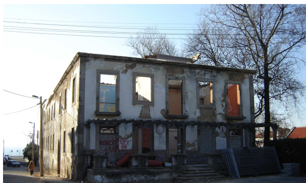
Fig.2 – Obras de recuperação do Hotel da Granja (2005)
